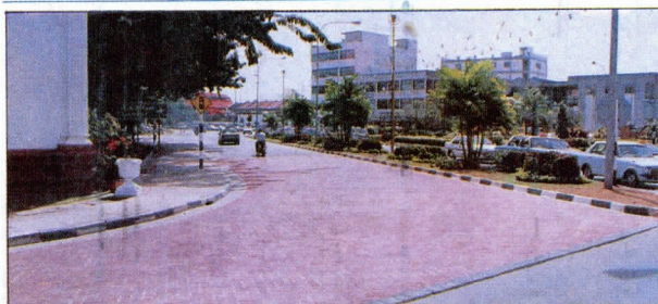
JALAN interlocking concrete paver yang dibina di simpang Lebuhraya Darulaman berhadapan Balai Seni Negeri sebagai satu percubaan awal sebelum pembinaan secara meluas dilakukan.
